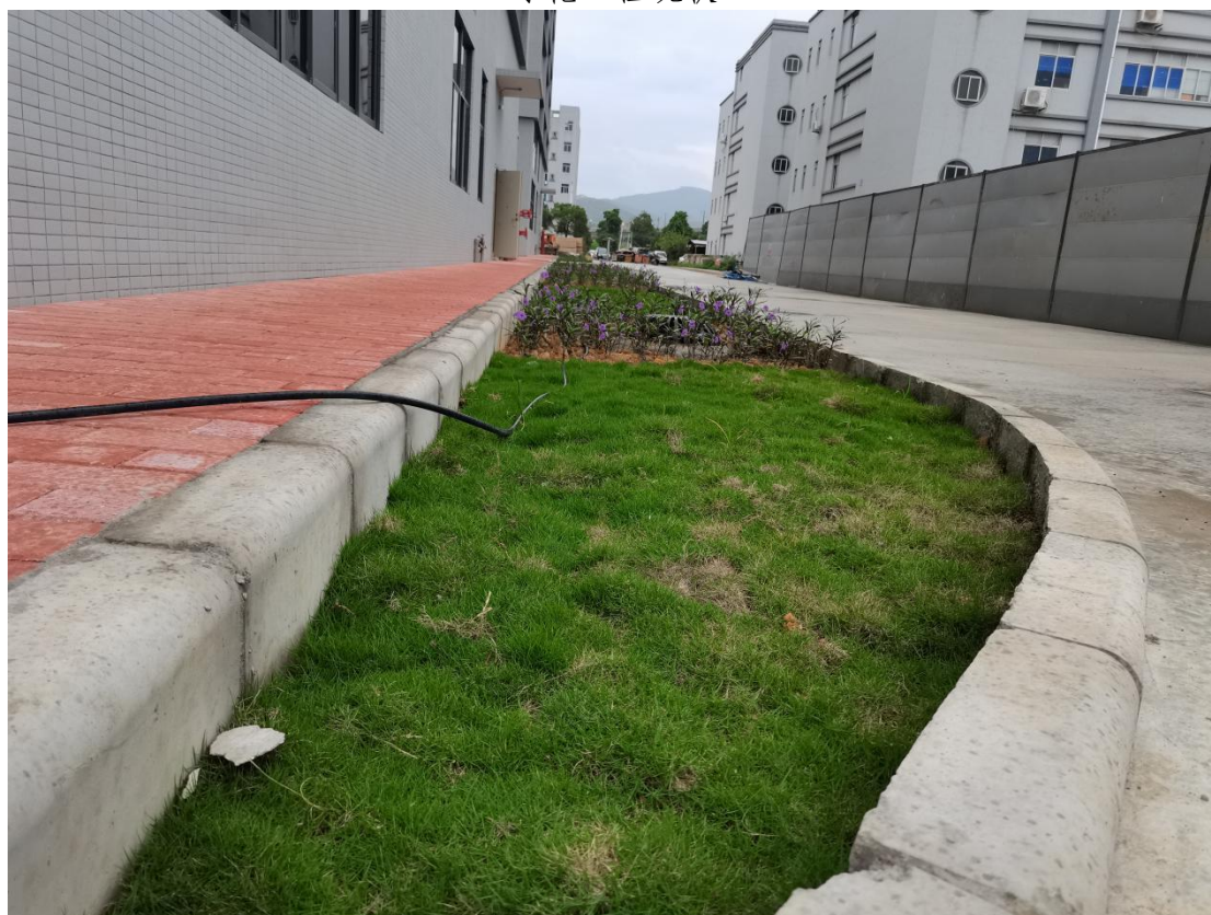
绿化工程现状
