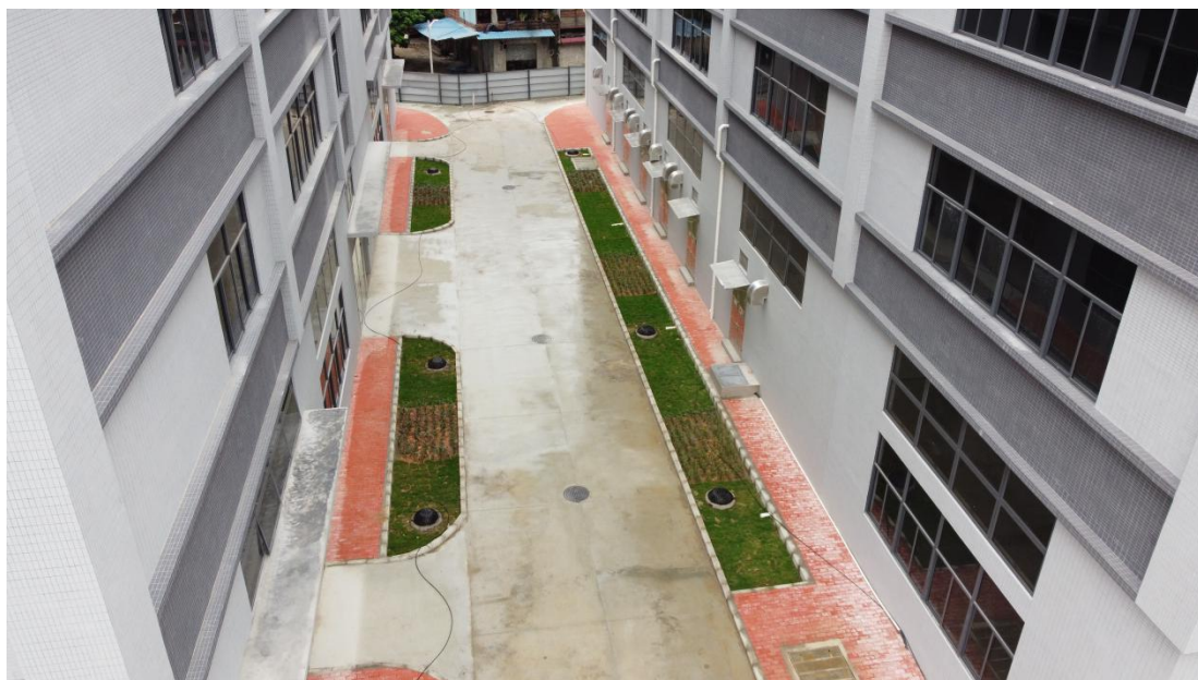
绿化工程现状
