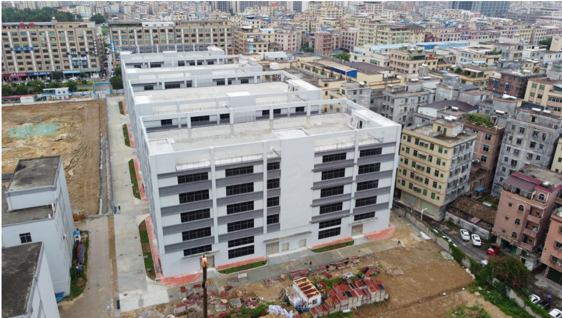
主体工程现状
