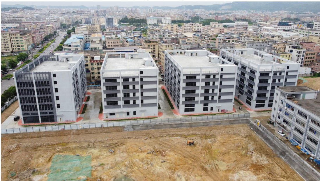
主体工程现状
