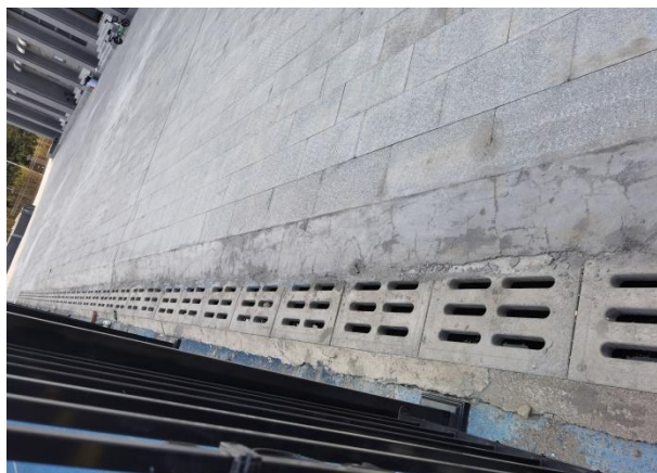
永久性排水措施
