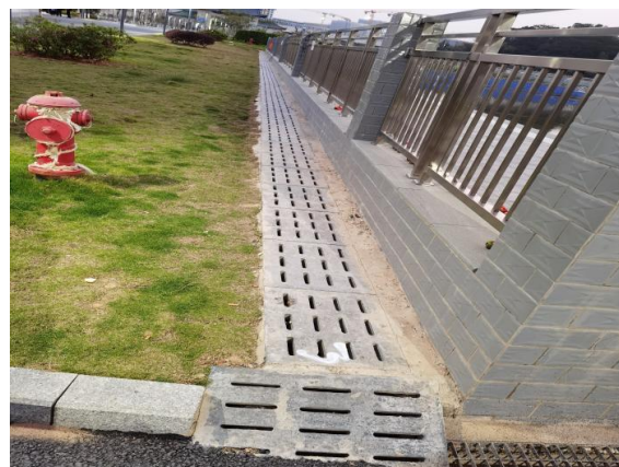
永久性排水措施
