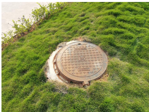
永久性排水措施
