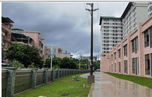
排水设施现状
