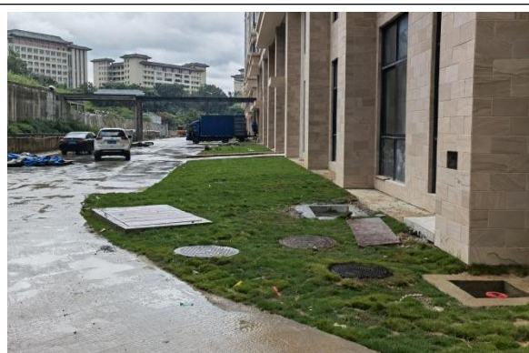
排水设施现状
